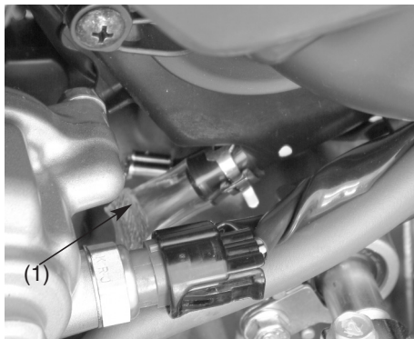
(1) Tubo de drenaje
