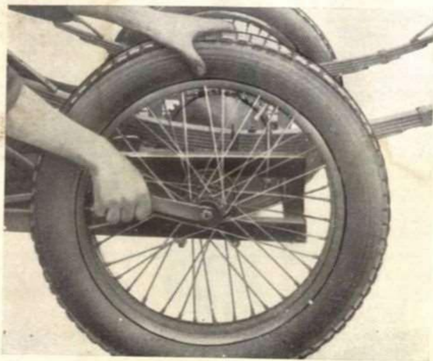
Fig. 101 - A 32 Chiave piatta esagonale per dadi copri polvere ed interni ruote
